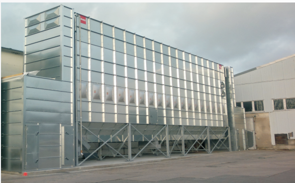
Reihenfilter mit Spülluftabreinigung
