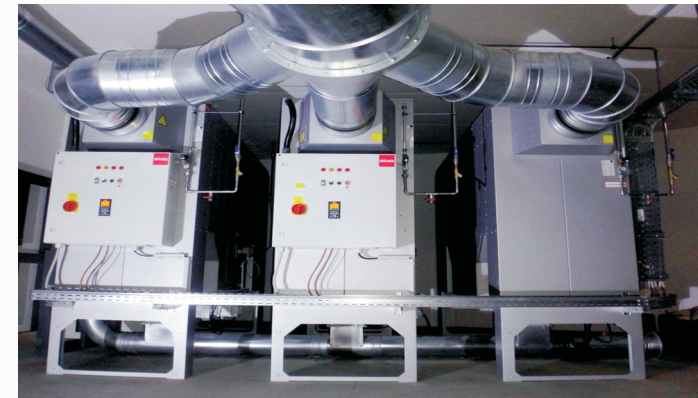
Bild 4: Luftmengenkapazität 30.000 m³/h
