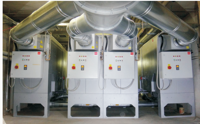
Bild 1: Luftmengenkapazität 40.000 m³/h
