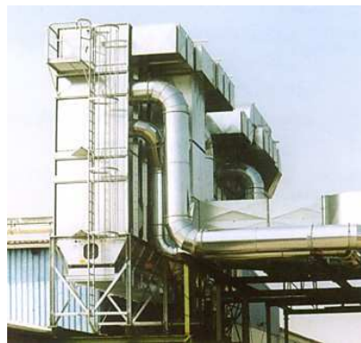
Filtr szeregowy z oczyszczaniem powietrza przepływającego
